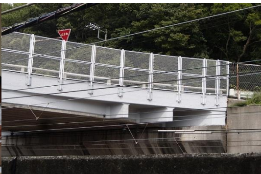
内原跨線橋及び人道橋 133,243,951円
