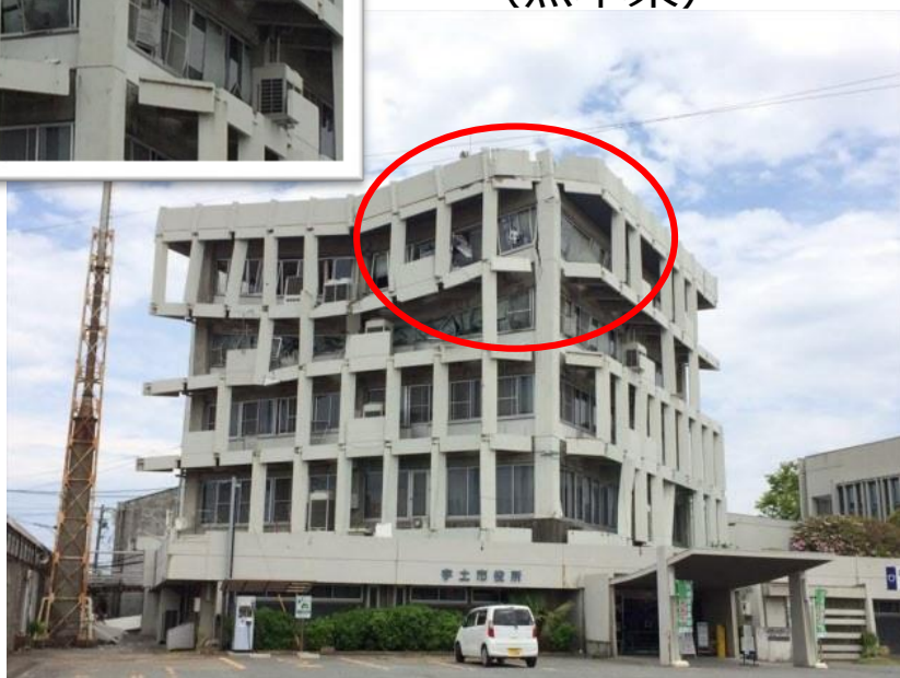
2回の震度7を受け大破した 宇土市役所庁舎 (熊本県)
