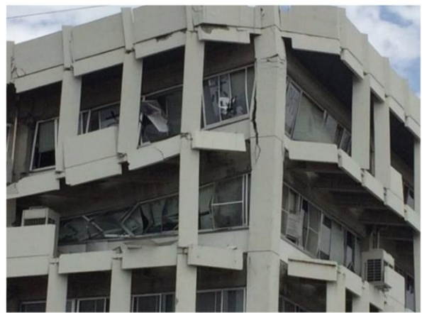
2回の震度7を受け大破した 宇土市役所庁舎 (熊本県)
