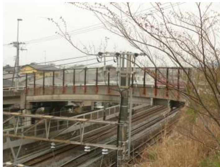
町道271及び27号線 橋りょう
