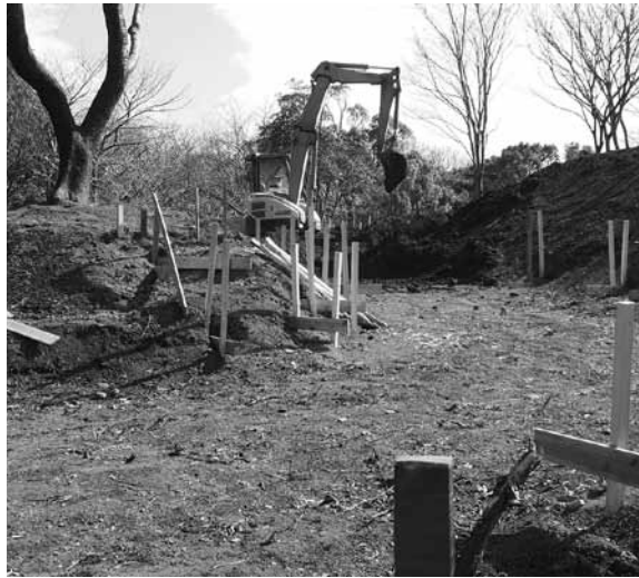
吾妻山の良さを生かせる工事となるか…
