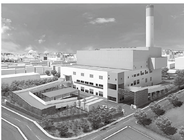
安定・安全・安心な 廃棄物処理の確立へ前進 (上図は平塚市の(仮称)次期環境事業センター)
