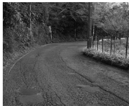
整備される町道63号線 新ごみ積替施設予定地前
