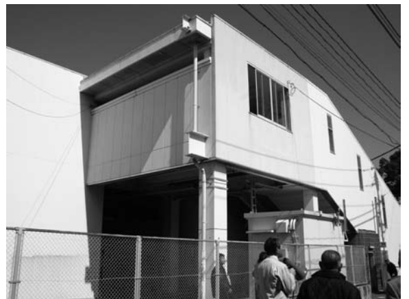
駅南北の自由通路にエレベーターが設置されます
