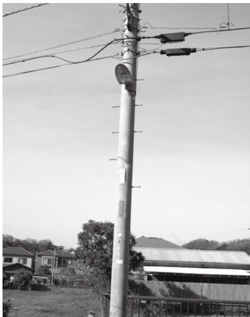
町内でも設置され始めたLED防犯灯
