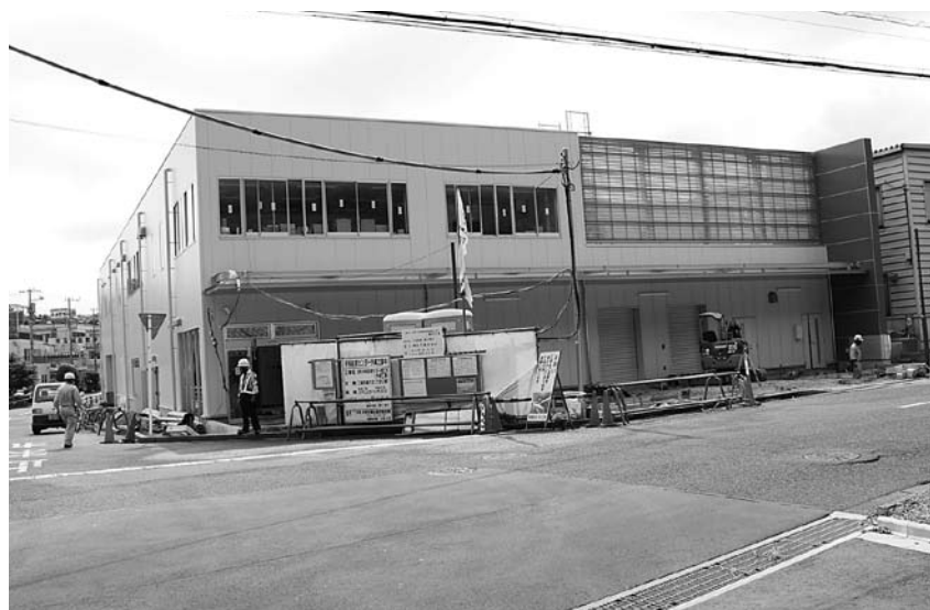
2年がかりの予算で新設された新学校給食センター (2学期より新施設での給食が始まる)
