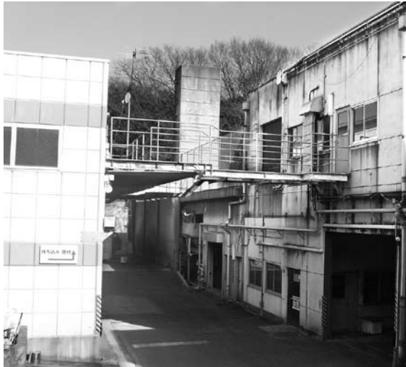
脱水汚泥を焼却していた煙突が今も残る
