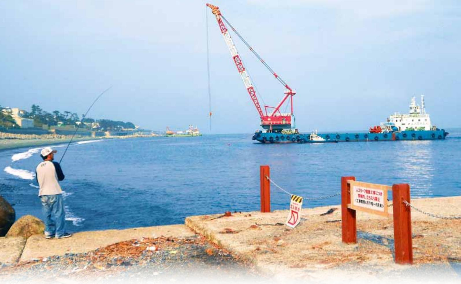
潜堤工事は16tの消波ブロックを654個沈めた
