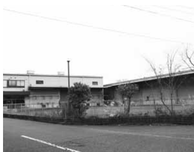
施設の建設予定地 (緑が丘一丁目工業団地内)
