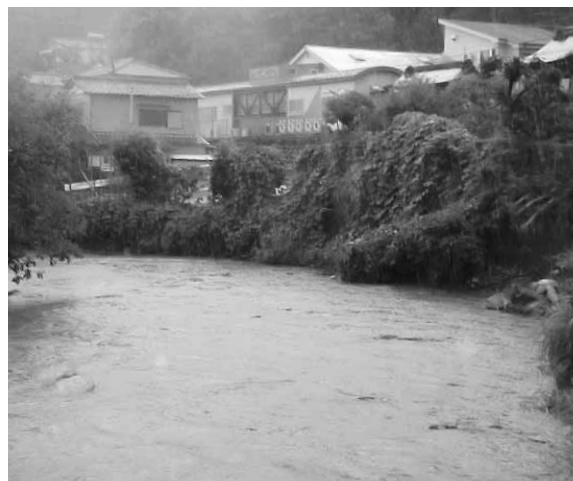
増水し濁流と化す葛川の恐怖 対策を急げ！
