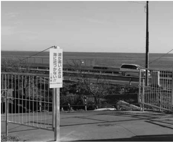
立ち入り禁止扉を設置
