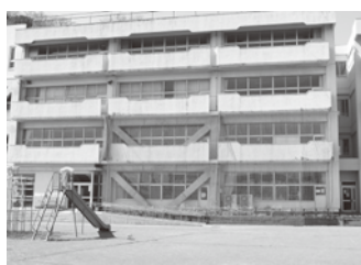
改修予定の西側校舎
