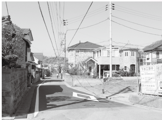
前年度に引き続き越地児童館前の 山西污水幹線整備工事
