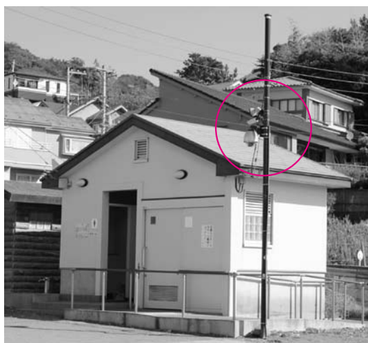
梅沢海岸、高波・津波の監視カメラ
