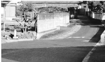
緊急車両が通行できない町道38号線 (右が二宮町、左が小田原市)
