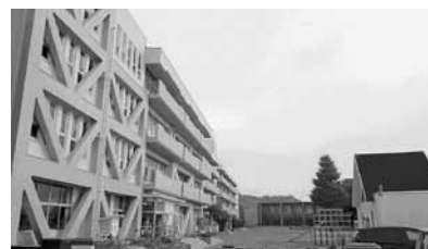
大規模改修工事を終えた 二宮小学校
