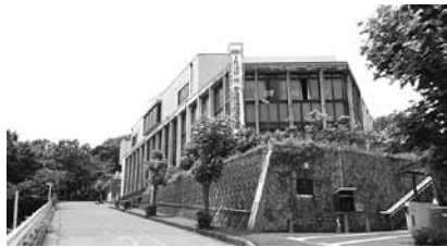
耐震化が進んでいない二宮町役場庁舎
