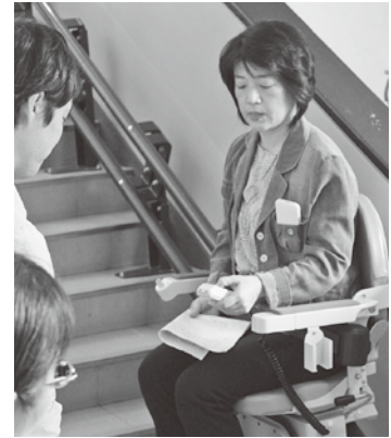
安心の学校生活へ一歩前進！ バリアフリー化の一環で 西中学校に昇降機が整備された
