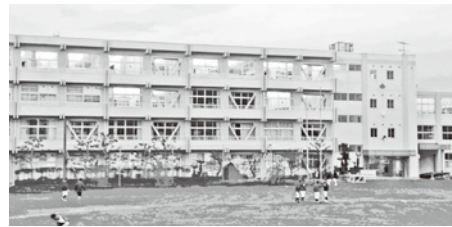
待たれる小中学校へのエアコン設置 (写真は二宮中学校)
