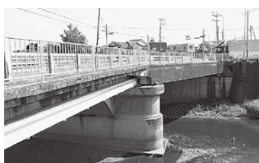
平成23年度に改修された 国道1号線押切橋
