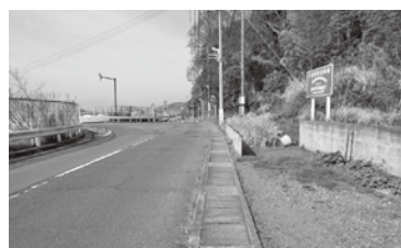
歩道はどこ？危険な箇所は早急に整備を！
