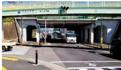
県道JR高架下の冠水現場
