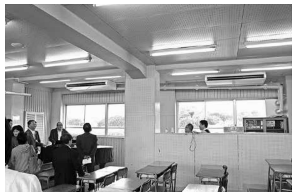
昨年度設置した、二宮中学校音楽室のエアコン
