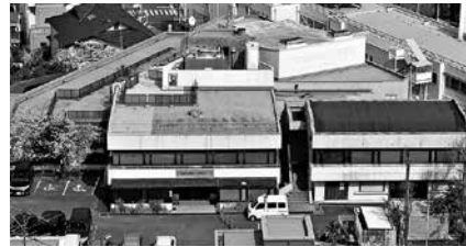
耐震性の問題指摘から20年未耐震の町役場庁舎
