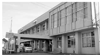
空き校舎を利用した西会津町役場庁舎
