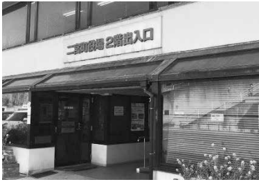
老朽化が進む現役場庁舎
