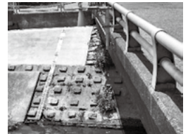
花月橋に設置された 簡易水位計と量水標
