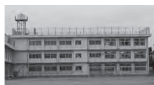
外壁等大規模改修する 二宮中学校特別棟
