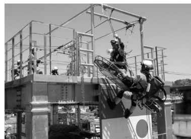
消防力向上に多面的効果 （新たな訓練施設）
