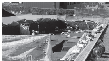
新庁舎整備向け埋蔵文化財発掘調査が進む現場
