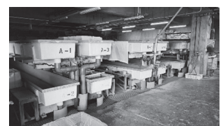
ウニ畜養殖設備(多段水槽)をプール槽内に設置(例)
