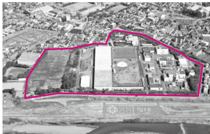
酒匂川流域下水道 酒匂水再生センター (左岸処理場 = 東側)
