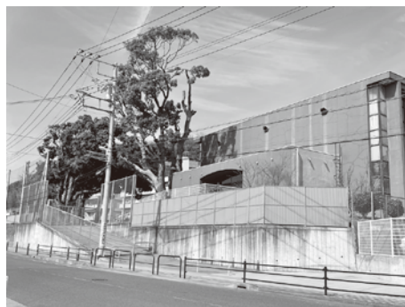
老朽化が進む、二宮小学校体育館。 小中一貫教育校は施設一体型へ。
