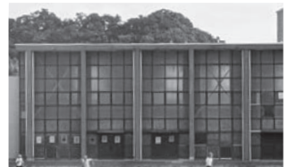
建物健全度点数の低い 二宮小学校体育館
