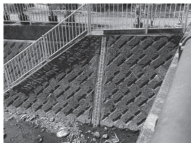
新たに設置された新田橋の水量計。葛川の早期整備を望む
